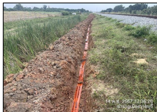
รูปที่ 1-11 งานก่อสร้าง Cabel Trench and Laying Cabel บริเวณสถานีบ่อตะคร้อ
