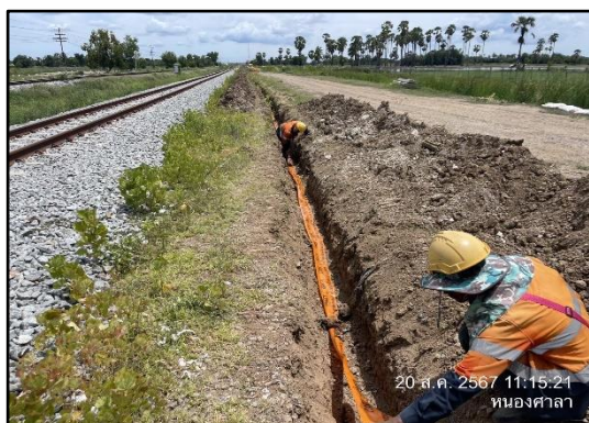
รูปที่ 1-13 งานก่อสร้าง Cabel Trench and Laying Cabel บริเวณสถานีหนองศาลา
