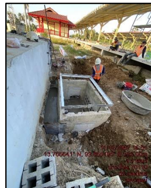
รูปที่ 1-8 งานก่อสร้างท่อรองรับ Cable Trench and Laying Cable ช่วงข้ามสะพานรถไฟ บริเวณสถานีนครปฐม
