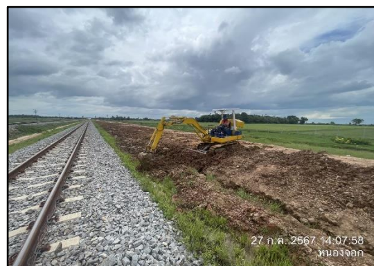
รูปที่ 1-13 งานก่อสร้าง Cabel Trench and Laying Cabel บริเวณสถานีหนองศาลา
