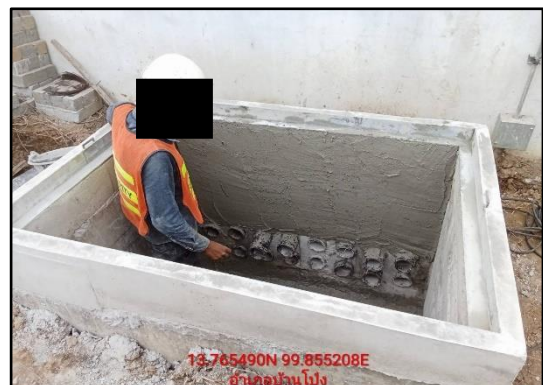
รูปที่ 1-9 งานก่อสร้าง Main Cable Pit บริเวณสถานีนครปฐม
