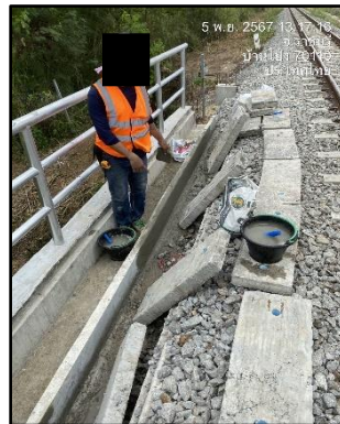
รูปที่ 1-8 งานก่อสร้างท่อรองรับ Cable Trench and Laying Cable ช่วงข้ามสะพานรถไฟ บริเวณสถานีนครปฐม
