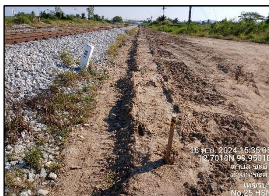
รูปที่ 1-14 งานก่อสร้าง Cabel Trench and Laying Cabel บริเวณสถานีห้วยทรายเหนือ
