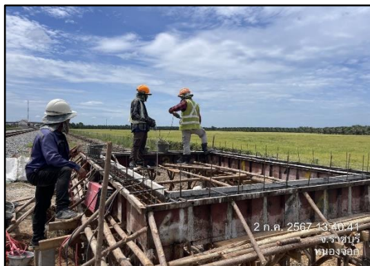
รูปที่ 1-10 งานก่อสร้างฐานตู้สื่อสาร (LOC). บริเวณโรงเรียนบ่อตะคร้อ
