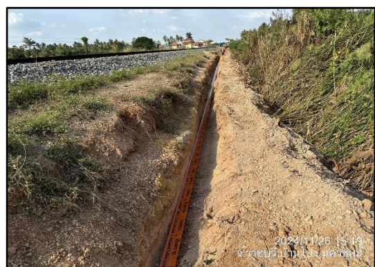
รูปที่ 1-7 งานก่อสร้าง Cabel Trench and Laying Cabel บริเวณสถานีนครปฐม
