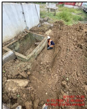
รูปที่ 1-8 งานก่อสร้างท่อรองรับ Cable Trench and Laying Cable ช่วงข้ามสะพานรถไฟ บริเวณสถานีนครปฐม
